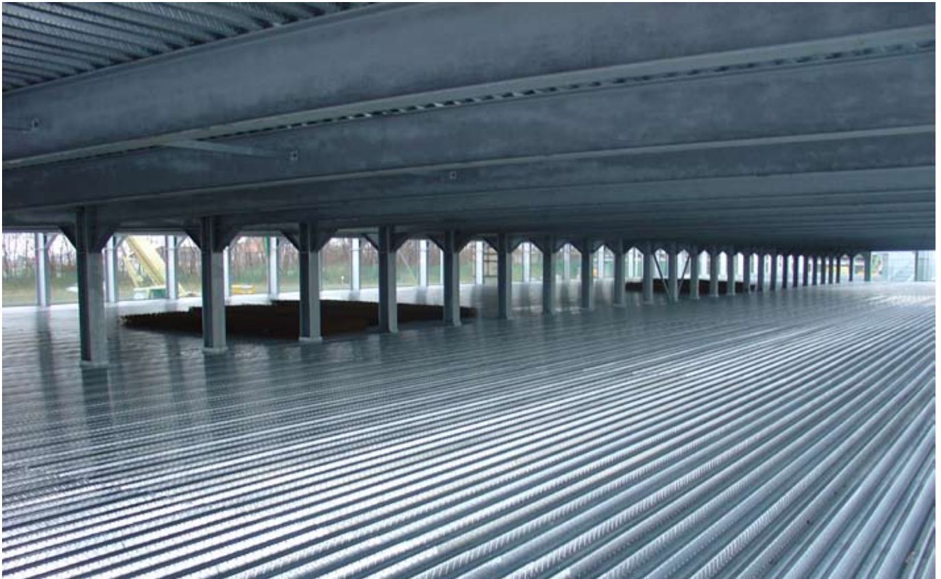
Figuur 1-8 : Voorbeeld van constructie met niet-onderstempelde staalplaat-betonvloer
